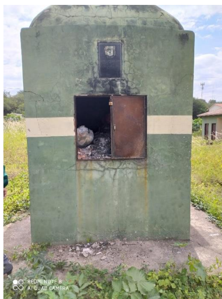
Fotografía No. 4 horno antiguamente utilizado para residuos bioinfecciosos
